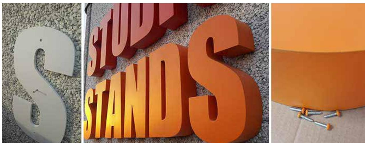
L'allestimento inizia con l'installazione a parete di un fondello in pvc utilizzando semplicemente un trapano. Successivamente le lettere vengono fissate una ad una sul fondello con apposite viti. L'eventuale utilizzo di viti con teste verniciate del colore delle lettere permette di renderle praticamente invisibili ad installazione ultimata.
